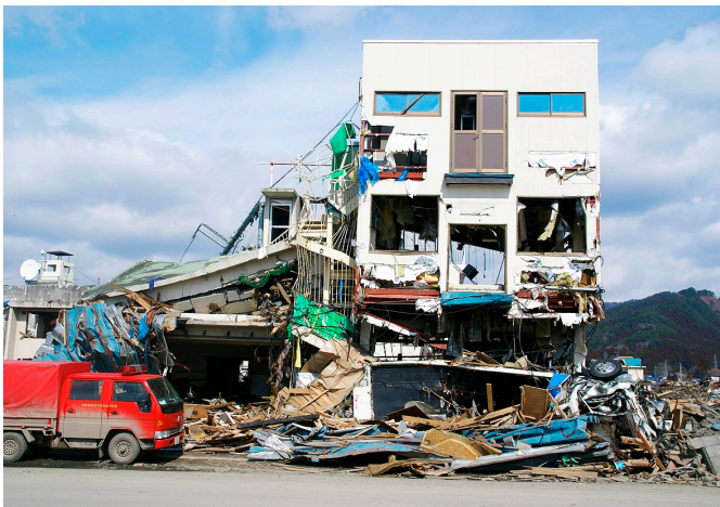
津波被害を受けた庁舎（消防署）の状況 (写真提供：釜石・大槌地区地域行政事務組合消防本部)
