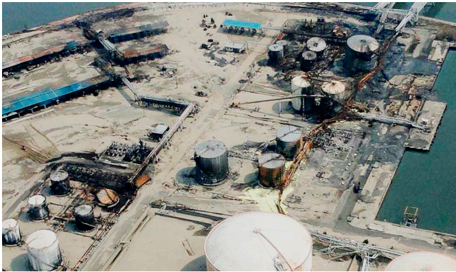
津波により火災が発生した製油所の状況（宮城県多賀城市） (写真提供：塩釜地区消防事務組合消防本部)
