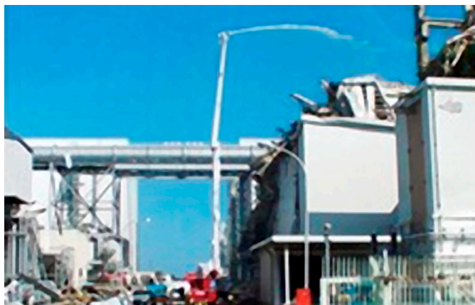
緊急消防援助隊による3号機への放水 (写真提供：東京消防庁)
